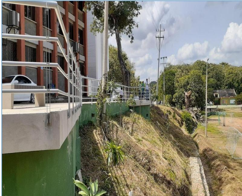
**Instalación de rejilla metálica en registro de aguas lluvias y construcción de viga en concreto de protección sendero peatonal**
