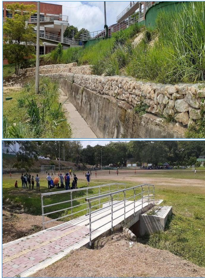
Instalación de gaviones en piedra sajón, cunetas, puentes en zona deportiva e instalación de barandas en tubería galvanizada
