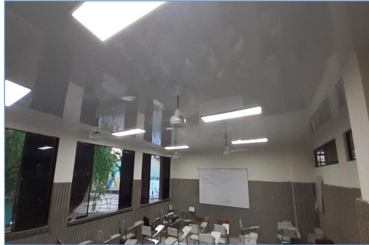
Reparación de cielo raso en mal estado en bloque de aulas incluye desmonte de lámparas y ventiladores
