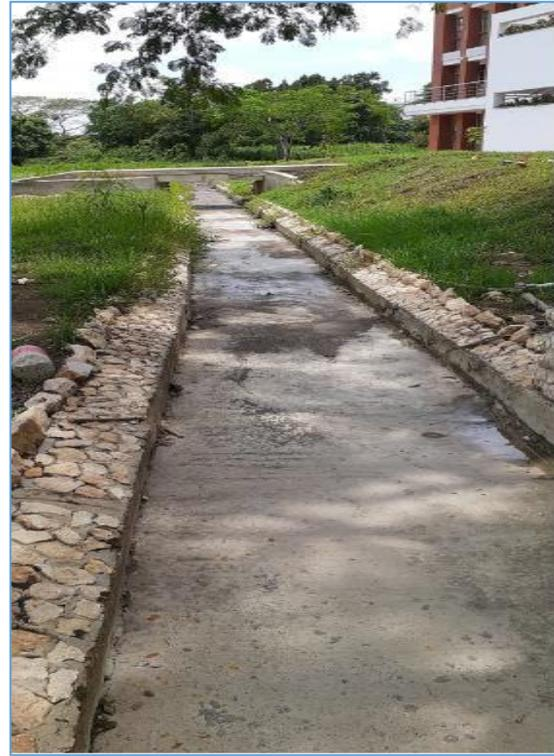
**Instalación de talud enrocado con base en concreto reforzado y cunetas zona de cancha de fútbol**
