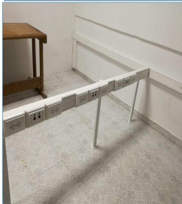
Instalación de cableado puntos eléctricos y adecuación general de la sala de sistemas del campus ciencias de la salud
