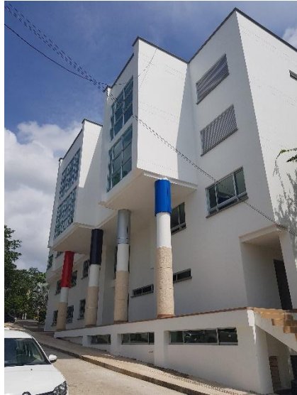
Imagen N° 3: Bloque de laboratorio de Ingeniería.
