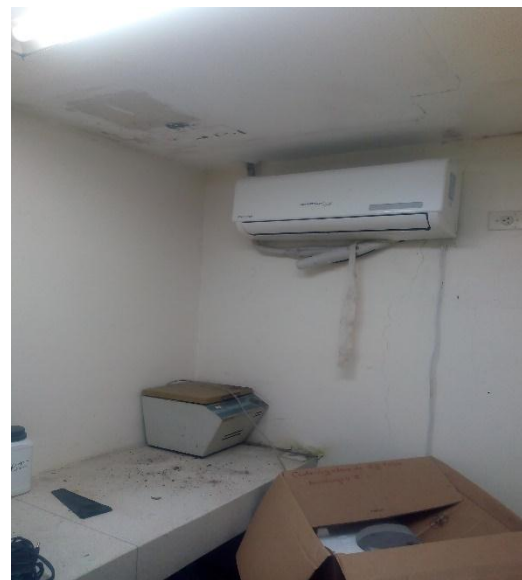
Imagen N° 13 y 14: Mal estado en cielo raso y cuarto interno sin aire acondicionado con detalles de humedad laboratorios campus puerta roja.
