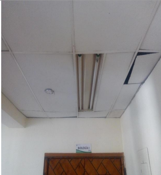
Imagen N° 13 y 14: Mal estado en cielo raso y cuarto interno sin aire acondicionado con detalles de humedad laboratorios campus puerta roja.
