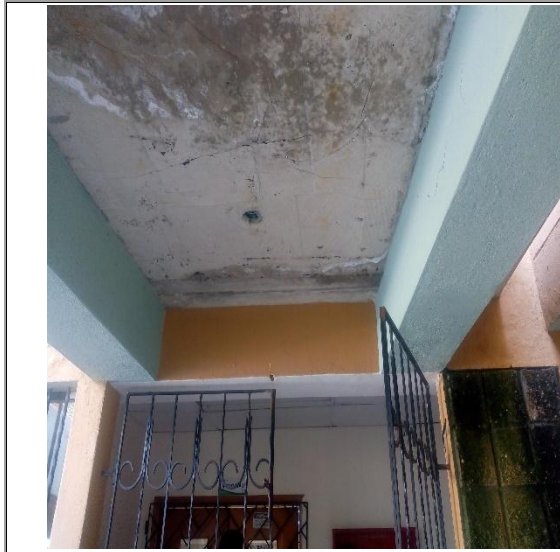
Imagen N° 11 y 12: Filtración en placa cubierta de rampa de acceso y Problemas de humedad en cuarto de equipos laboratorios campus puerta roja.
