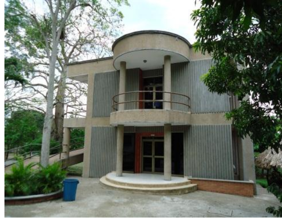
Foto 18. Bloque de Aulas
