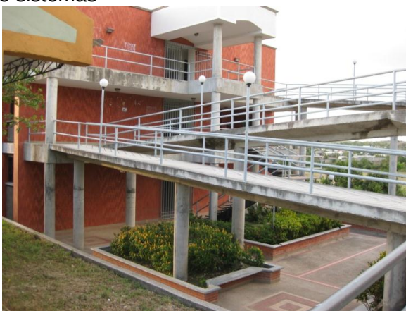
Bloque de Aulas
