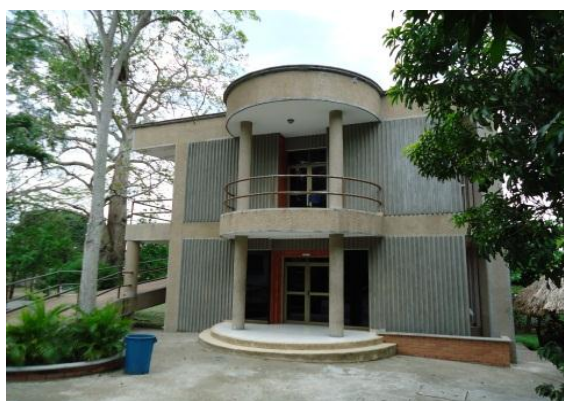
Bloque de Aulas
